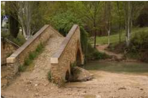
Puente de piedra de Riofrío.
